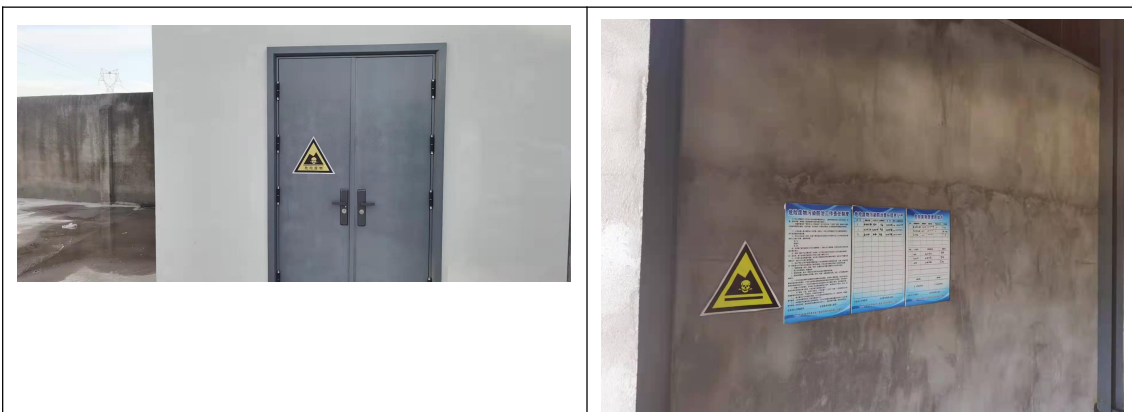
危废车间照片
