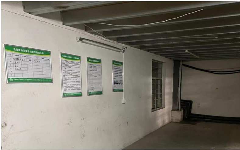
危废车间照片
