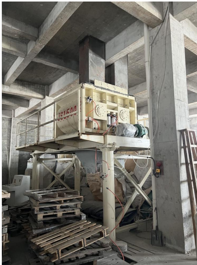
生产车间照片
