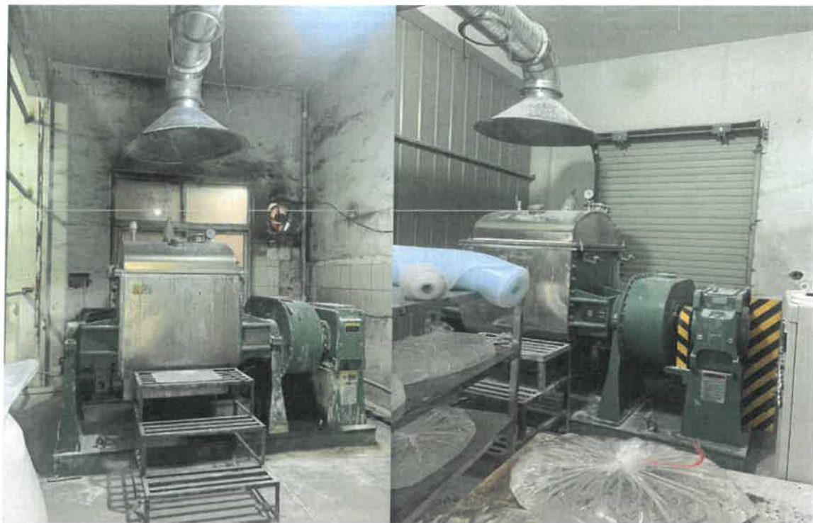
投料粉尘、密炼机已配备废气收集处理装置
