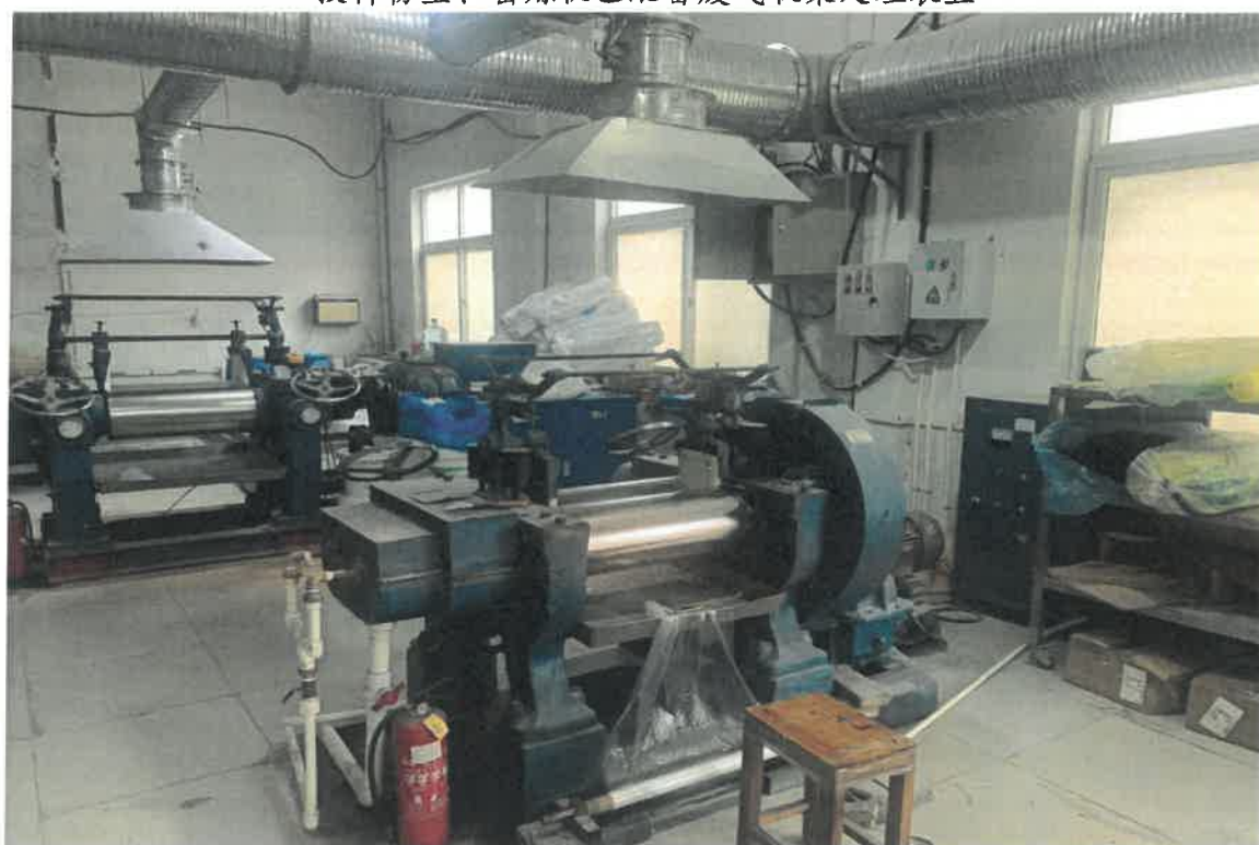
开炼机已配备废气收集处理装置
